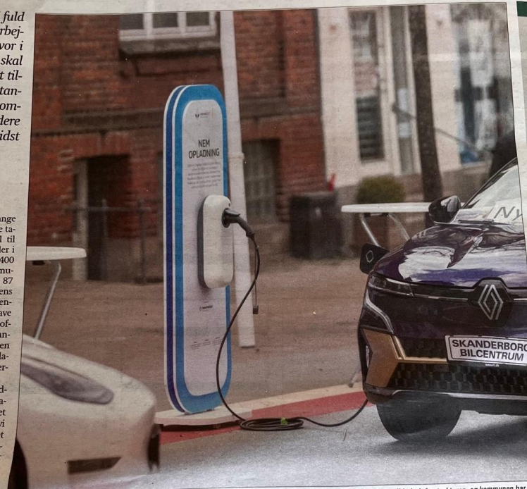
I 2030 vil der være 1 mio. elbiler på vejene i Danmark, og i Skanderborg vil der være ca. 13.400. Det stiller krav til ladeinfrastrukturen, og kommunen har pligt til at opsætte ladere ved offentlige bygninger med flere end 20 parkeringspladser. Foto: Per Bille
